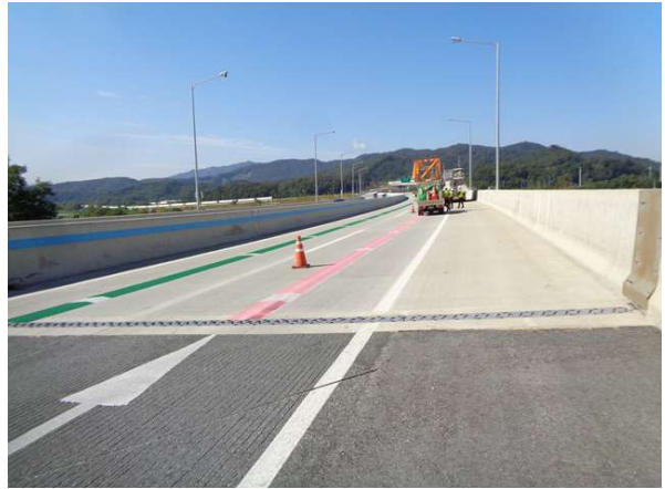
교량 상부 전경
