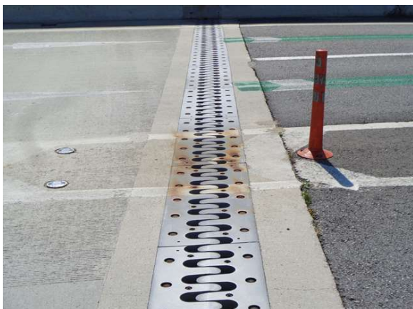
교량 상부 전경
