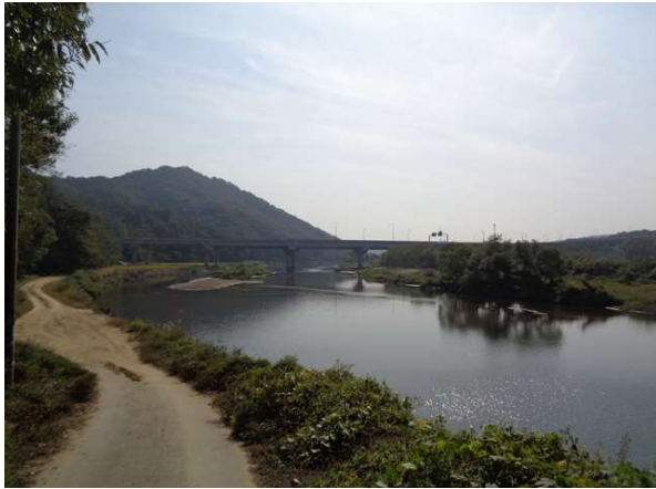
교량 측면 전경
