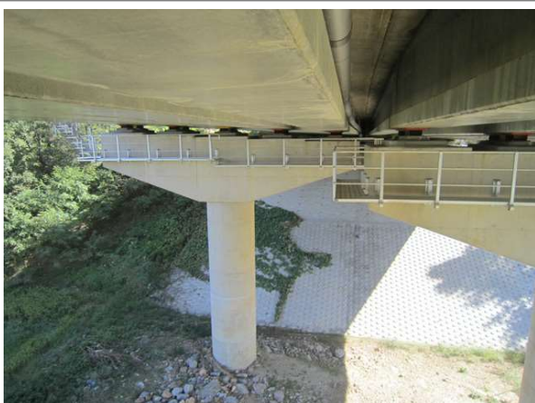
교량 하부 전경
