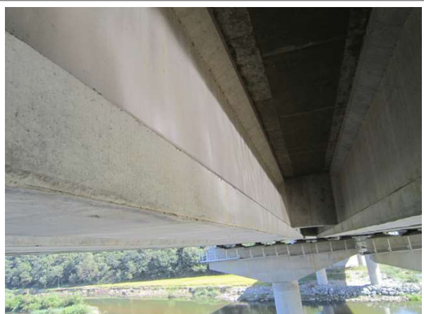
교량 거더 전경
