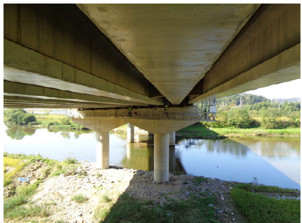
교량 하부 전경
